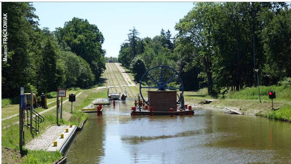
POCHYLNIA Z SZYNAMI, PO KTÓRYCH PRZEMIESZCZAJĄ SIĘ STATKI
