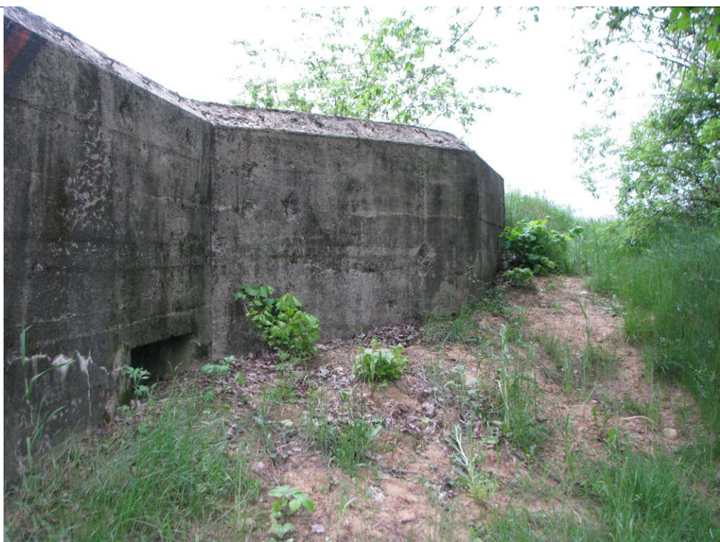
SCHRON WYBUDOWANY NA POTRZEBY WOJSKA POLSKIEGO W LATACH 30.
