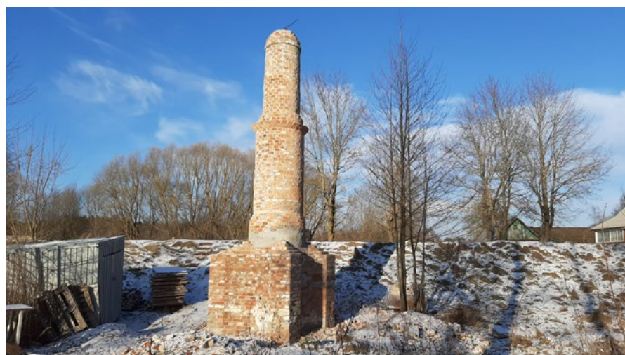
W TRAKCIE RENOWACJI KOLUMNY 3 MAJA
