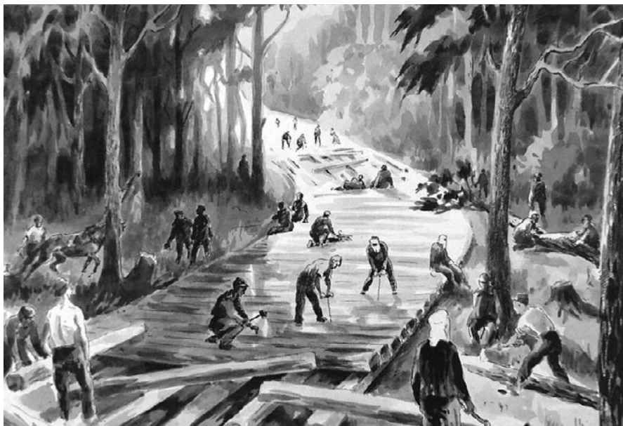
ZESŁAŃCY CIĘŻKO PRACUJĄ PRZY BUDOWIE DROGI PRZESZAJĄCE
