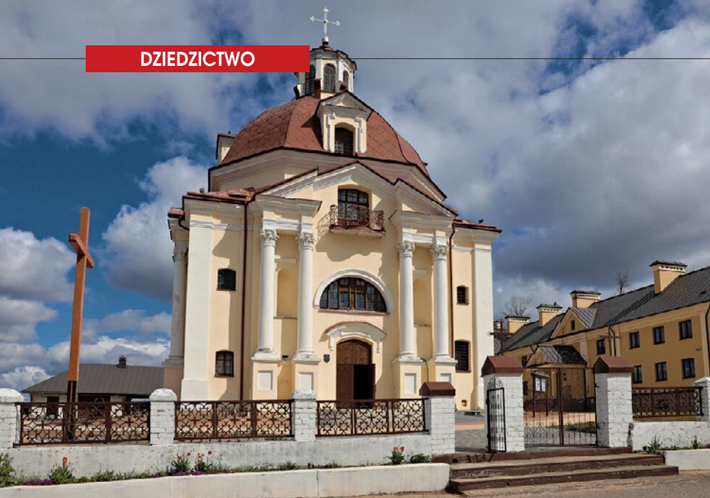
KOŚCIÓŁ PW. MATKI BOŻEJ SZKAPLERZNEJ I NOWY BUDYNEK KLASZTORU
