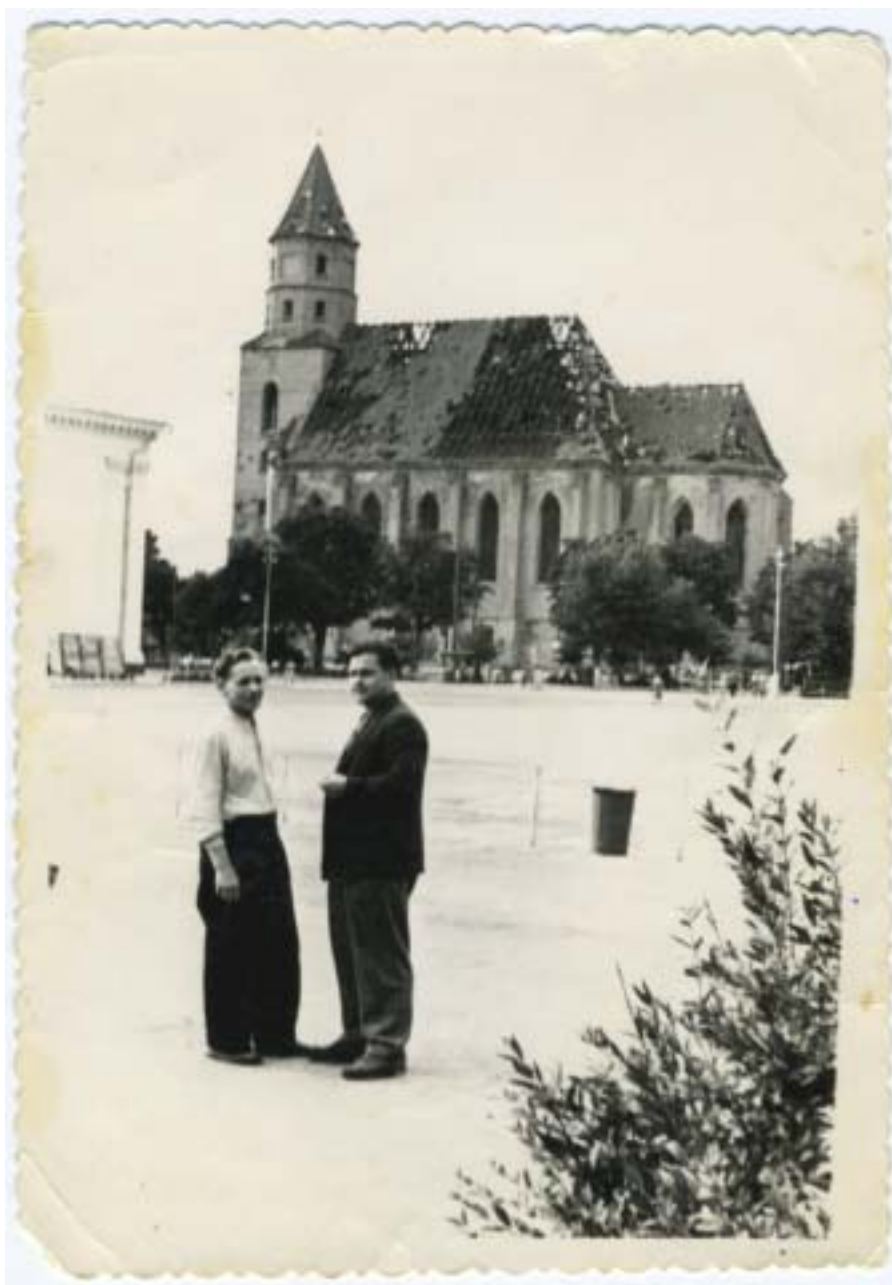
1960 r. ŚWIĄTYNIA JEST W DOBRYM STANIE, REMONTU WYMAGA JEDYNIENIE DACH. Z ALBUMU MARII POCZOBUT Z GRODNA
