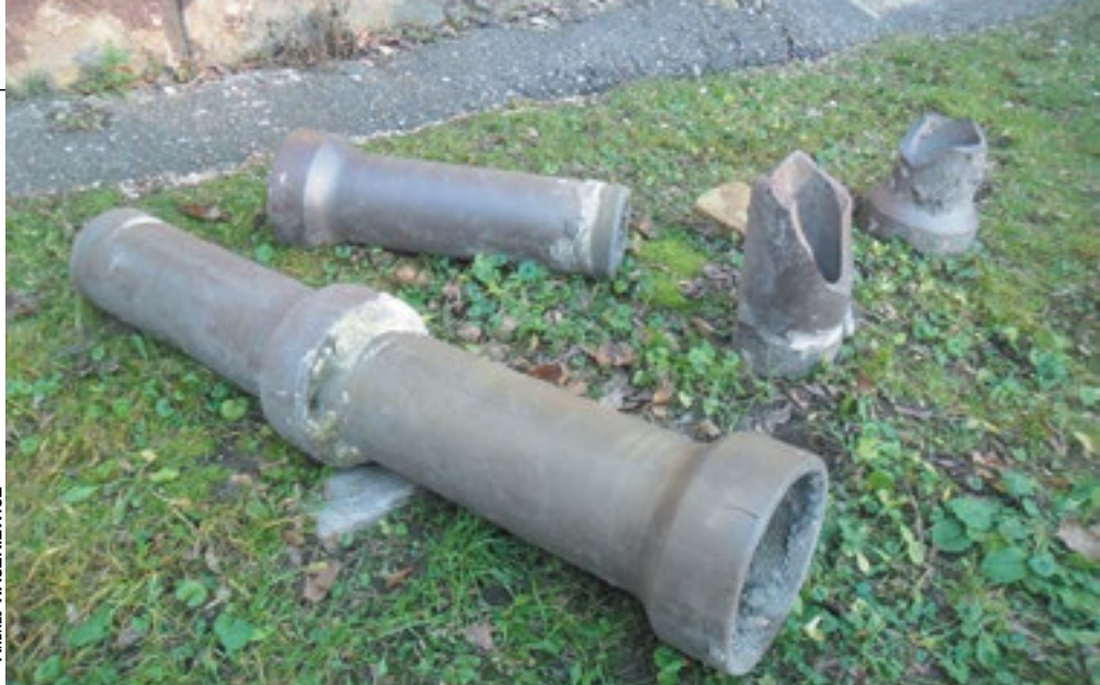
RURY KANALIZACYJNE Z NOWEGO ZAMKU, POŁOŻONE W LATACH 30. XX W.
